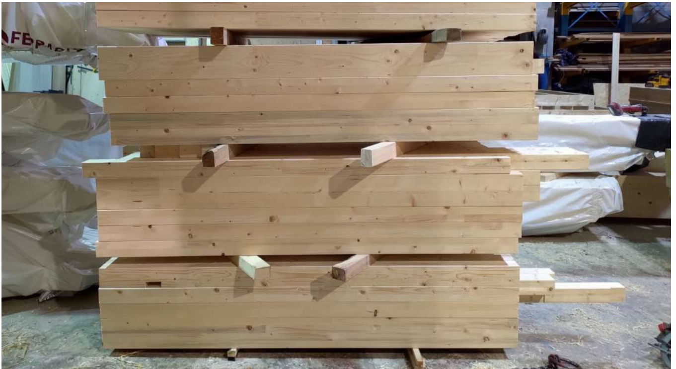
Travetti di legno che serviranno per formare il telaio prefabbricato dei muri
