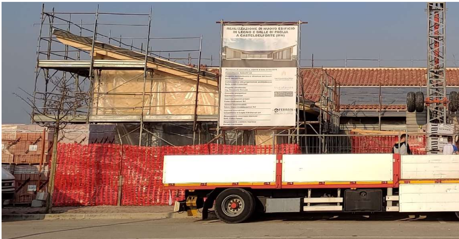
Il cantiere della villa al termine della posa del tetto (Gennaio 2020)
