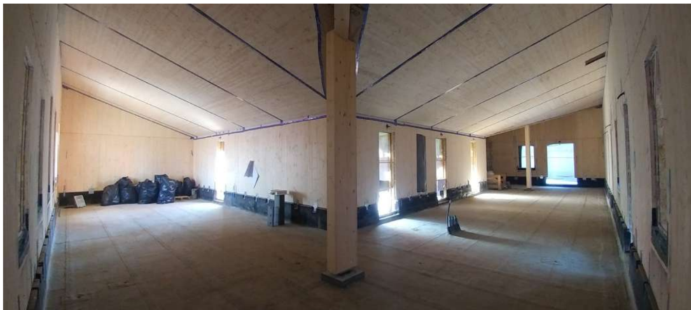
Uno scorcio interno della villa prima delle finiture interne
