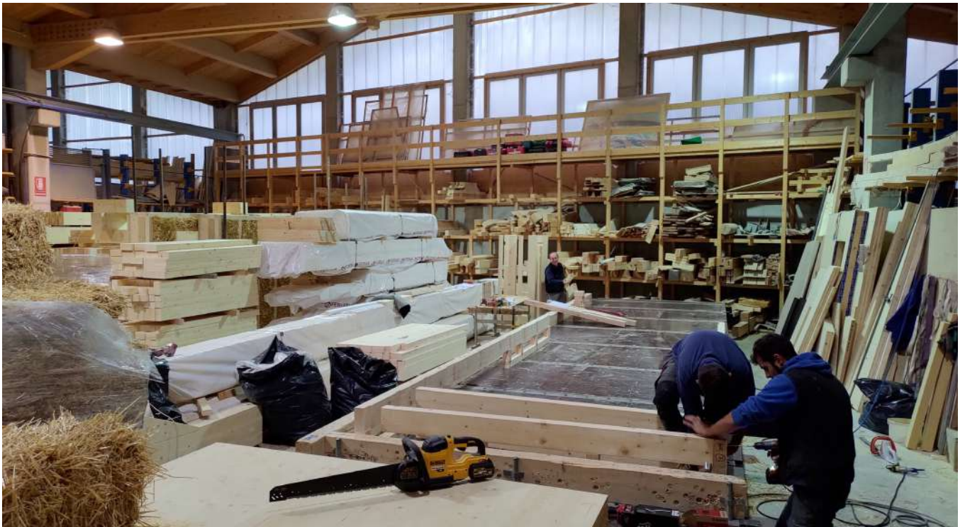
Inizio del montaggio dei pannelli prefabbricati in legno con struttura a telaio
