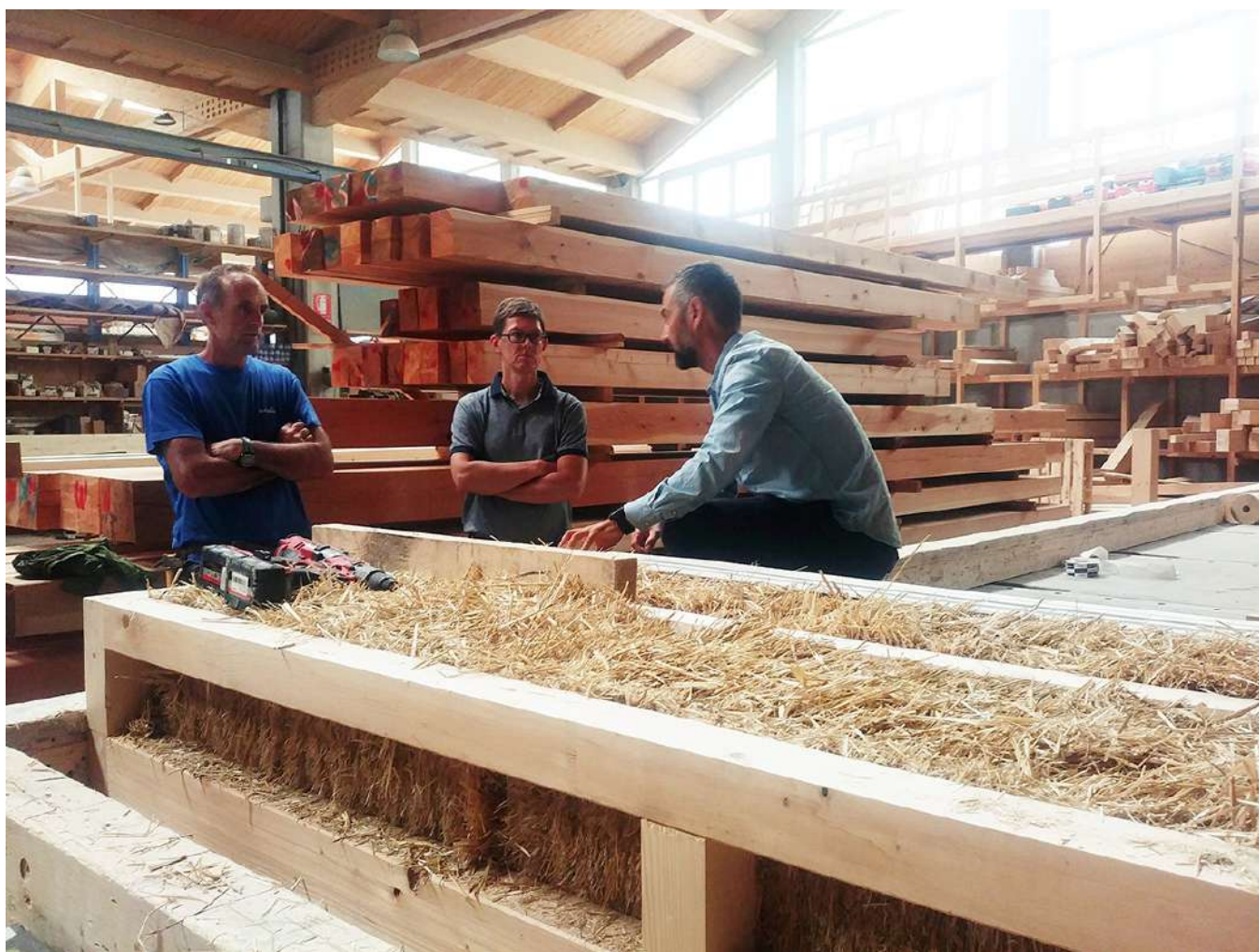
La costruzione del prototipo del muro in legno e paglia, frutto della condivisione tra l'architetto, l'ingegnere e il carpentiere (Carpenteria in Legno F.lli Ferrari - Settembre 2019)
